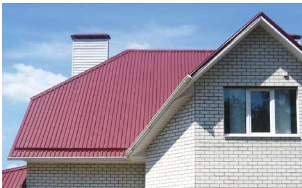
Рис. 108. Кровля из профилированного настила
