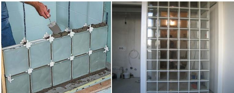
Рис. 27. Перегородки из стеклянных блоков
