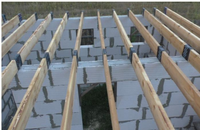
Рис. 65. Установка деревянных балок с гидроизоляцией опорных участков
