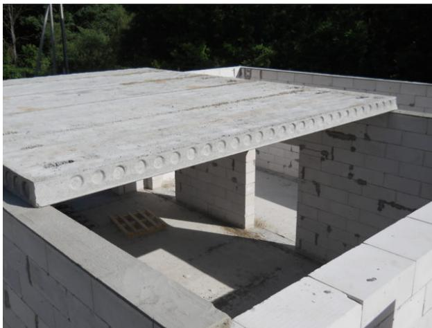
Рис. 53. Сборное железобетонное перекрытие из плит железобетонных круглопустотных
