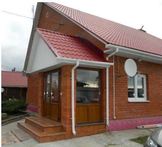
Рис. 160. Закрытая конструкция крыльца
