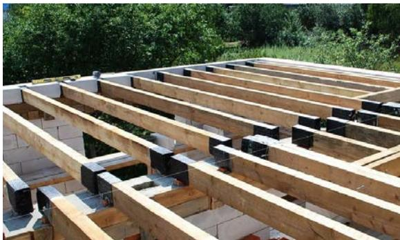
Рис. 57. Устройство перекрытия по деревянным балкам
