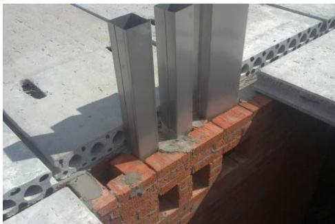
Рис. 60. Пропуск вентиляционных каналов через сборное железобетонное перекрытие
