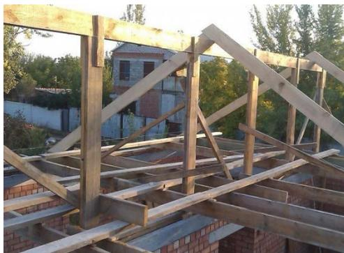
Рис. 95. Установка прогона
