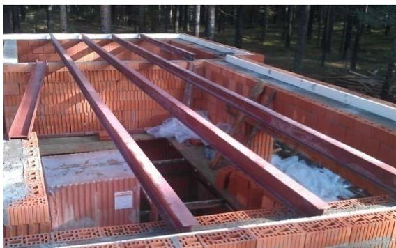
Рис. 58. Устройство перекрытия по металлическим балкам
