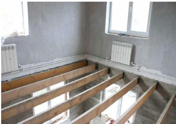
Рис. 50. Пример межэтажного перекрытия
