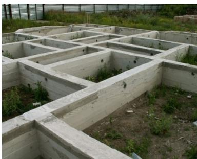
Рис. 36. Ленточные фундаменты по типу исполнения
