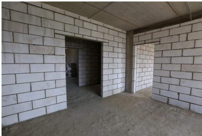
Рис. 24. Межкомнатные перегородки из газобетона
