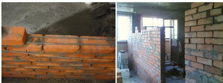
Рис. 26. Межкомнатные перегородки из кирпича
