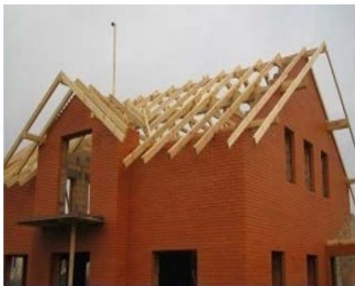
Рис. 96. Установка консольного прогона
