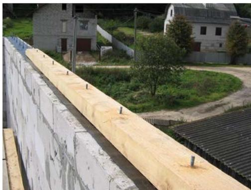
Рис. 94. Установка мауэрлата на наружную стену
