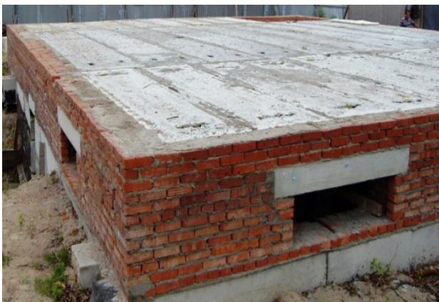
Рис. 51. Пример перекрытия над подвалом
