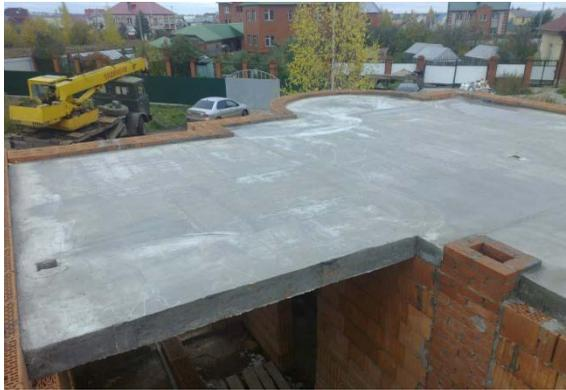
Рис. 54. Монолитное перекрытие
