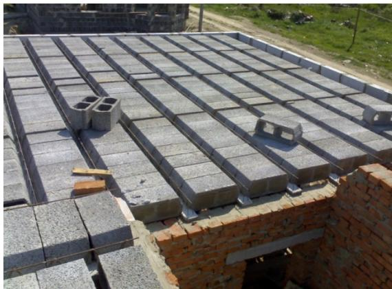
Рис. 56. Сборно-монолитное перекрытие
