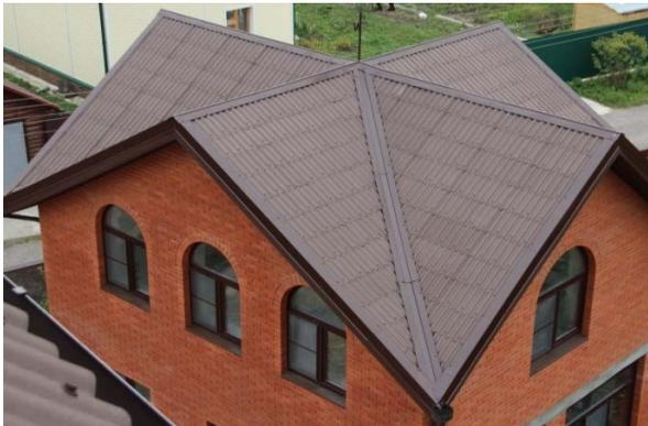
Рис. 126. Кровля из керамопласта
