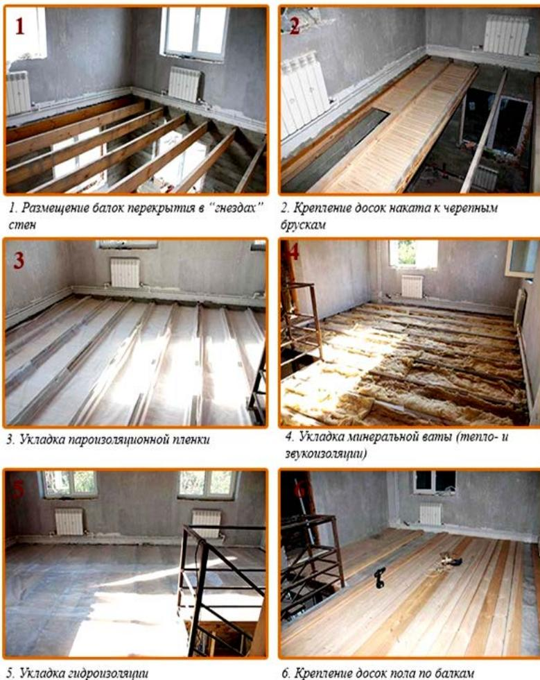
Рис. 67. Устройство перекрытия по деревянным балкам
