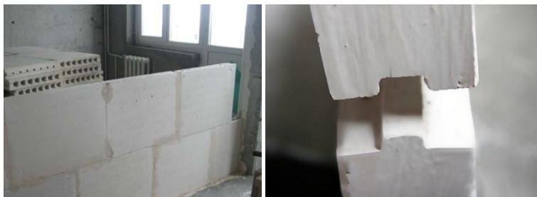
Рис. 25. Межкомнатные перегородки из пазогребневых гипсовых плит
