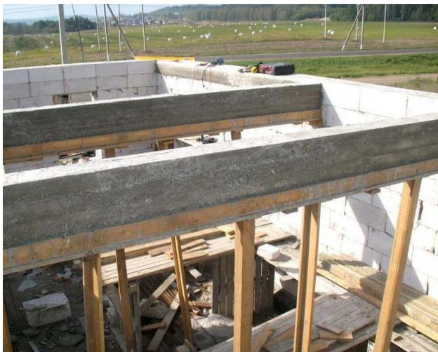
Рис. 59. Устройство железобетонных балок перекрытия на месте строительства
