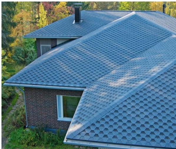
Рис. 119. Кровля из битумной черепицы
