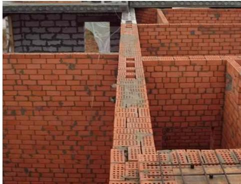
Рис. 17. Внутренняя стена жилого дома с вентиляционными каналами
