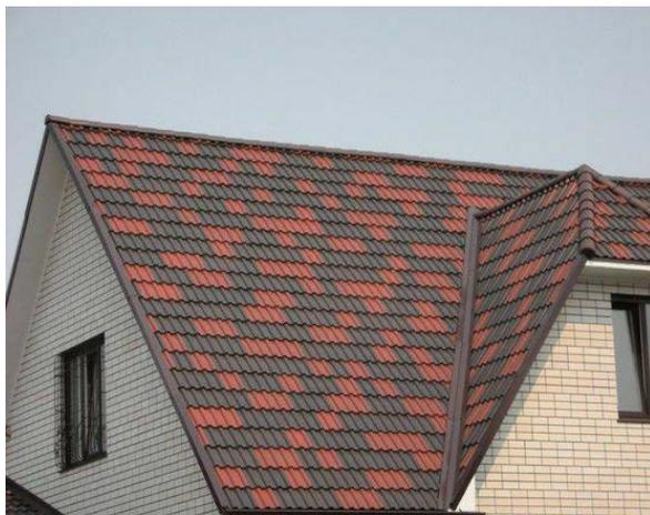
Рис. 116. Крыша из полимер-песчаной черепицы
