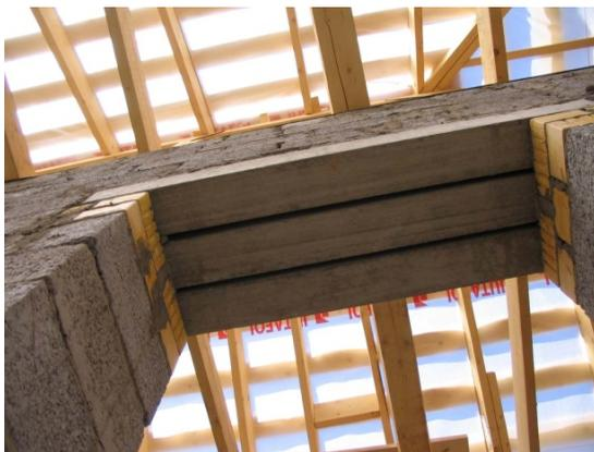
Рис. 79. Брусковые перемычки над дверным проемом
