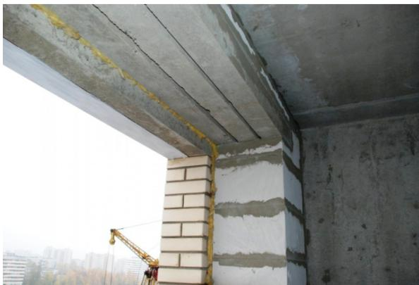
Рис. 74. Верхний простенок над оконным проемом
