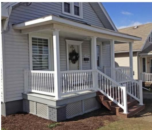
Рис. 159. Крытая конструкция крыльца
