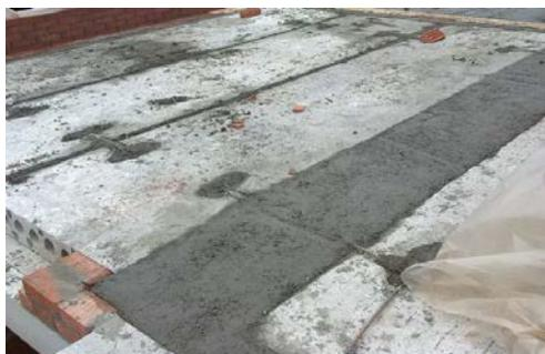
Рис. 61. Монолитный участок сборного железобетонного перекрытия
