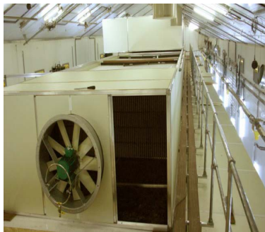
Рис. 2.27. Теплообменник
