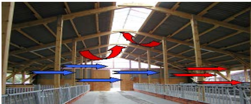
Рис. 50. Схема движения воздушных масс в коровнике
