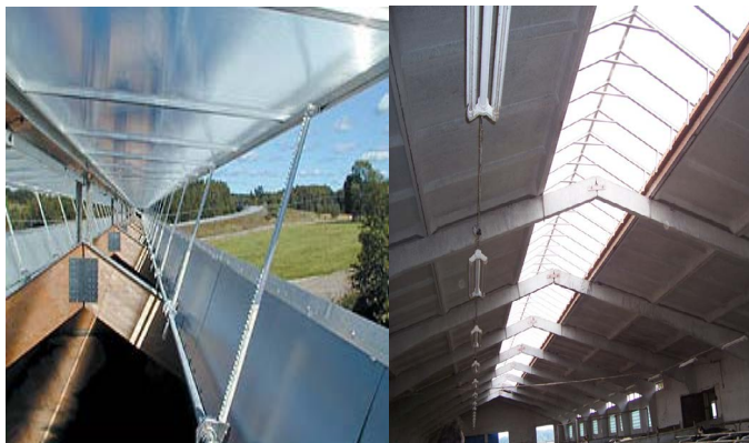
Рис. 51. Вентиляционный ( а ) и светоаэрационный ( б ) коньки
