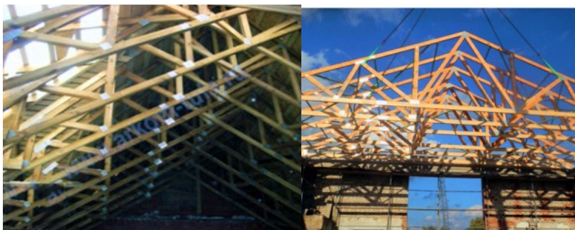
Рис. 32. Деревянные конструкции ферм
