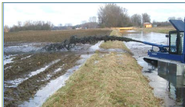
Рис. 8.6. Вид работы земснаряда-амфибии с выбросной трубой
