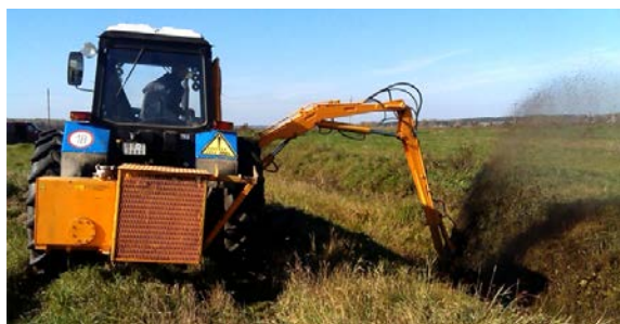
Рис. 3.3. ОКН-05 в работе с фрезерным рабочим органом (вид сзади)
