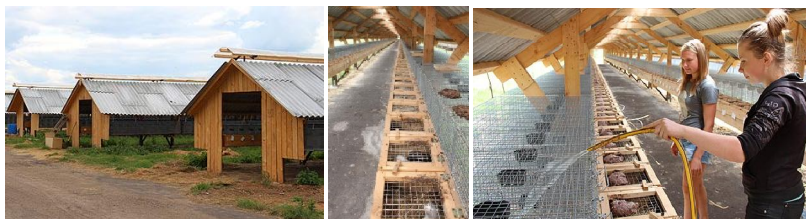
Рис. 26. Наружный вид и внутреннее устройство шеда
