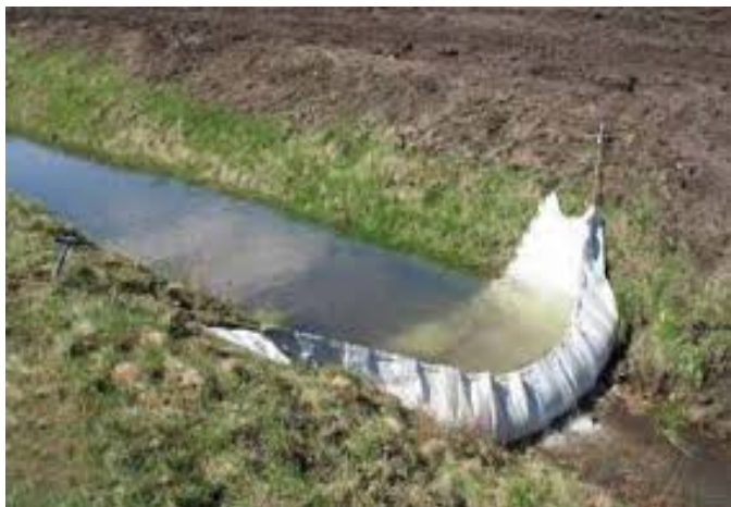
Рис. 11.17. Гибкая тканевая плотина
