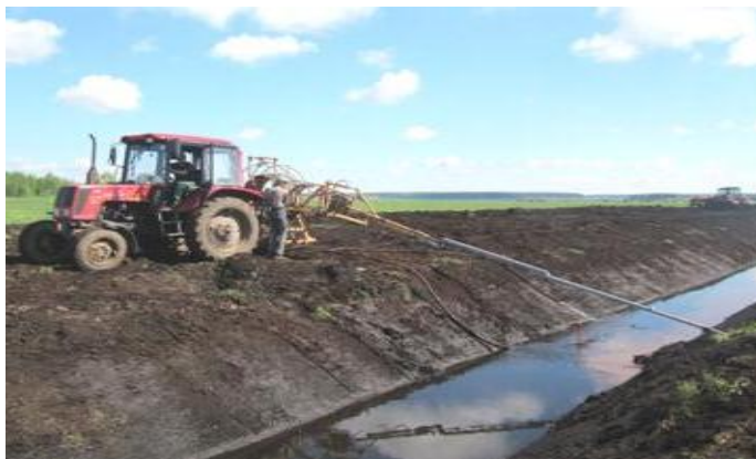
Рис. 11.14. Установка для промывки дренажа в работе по промывке коллекторной сети
