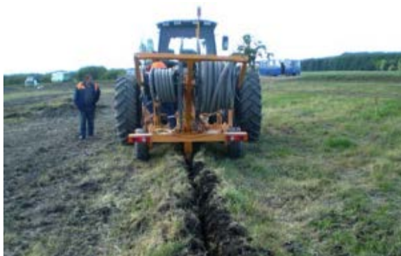
Рис. 11.7. Оборудование МДИ в работе
