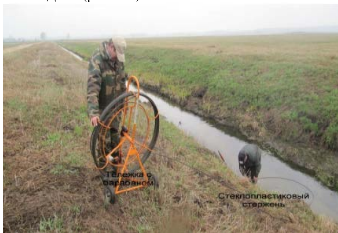
Рис. 11.9. Оценка внутреннего состояния коллектора с применением устройства ОД-100
