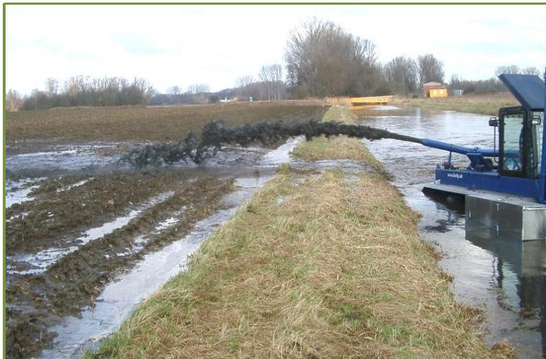
Рис. 6.6. Вид работы земснаряда-амфибии с выбросной трубой.
