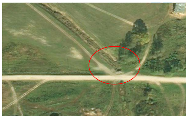
Рис. 2. Пример зарастания трубы-переезда кустарником
