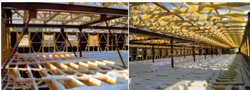
Рис. 28. Металлодеревянные фермы
