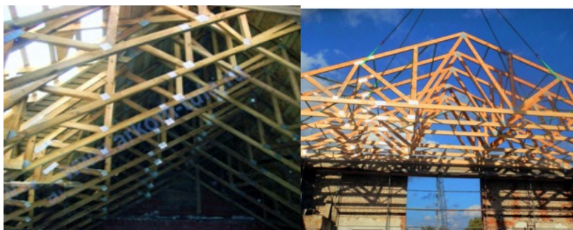
Рис. 27. Деревянные конструкции ферм
