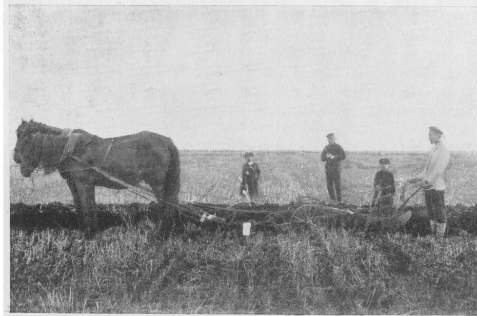
Динамометрическое испытаніе плуга.
