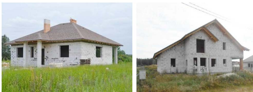
Рис. 1.3. Незавершенное законсервированное капитальное строение
