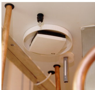
Рис. 1.38. Регулятор \text{CO}_2 и другие датчики контроля в предварительном инкубаторе
