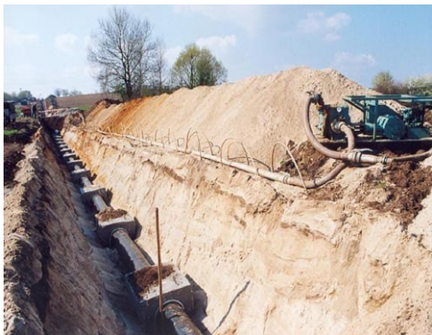
Рис. 8.2. Монтаж вытяжного коллектора
