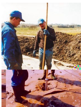
Рис. 8.1. Установка иглофильтров
