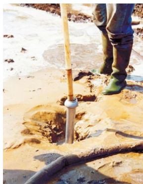
Рис. 8.1. Установка иглофильтров
