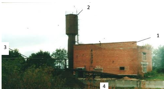
Рис. 2. Фрагмент технологической линии обработки стоков в ОСАО «Агрокомбинат «Слобожанский»: 1 – цех разделения стоков; 2 – устройство разделения стоков; 3 – трубопровод подачи жидкой фракции на карантин; 4 – твердая фракция
