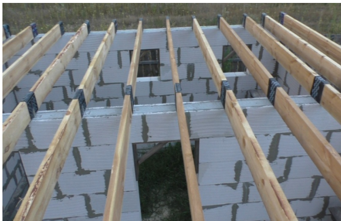
Рис. 65. Установка деревянных балок с гидроизоляцией опорных участков
