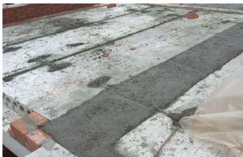
Рис. 61. Монолитный участок сборного железобетонного перекрытия
