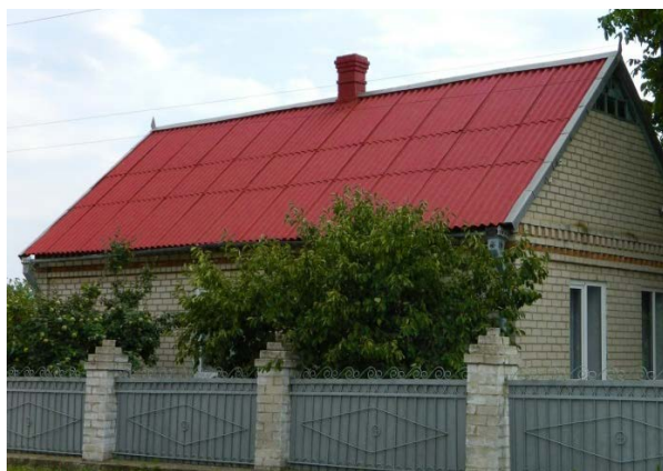
Рис. 121. Кровля из волнистых асбестоцементных листов
