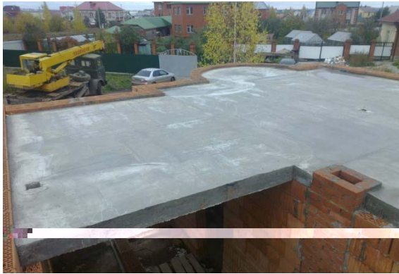
Рис. 54. Монолитное перекрытие
