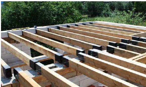
Рис. 57. Устройство перекрытия по деревянным балкам
