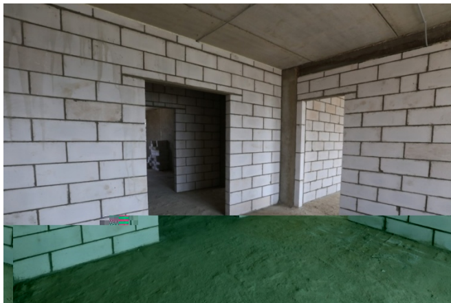
Рис. 24. Межкомнатные перегородки из газобетона
