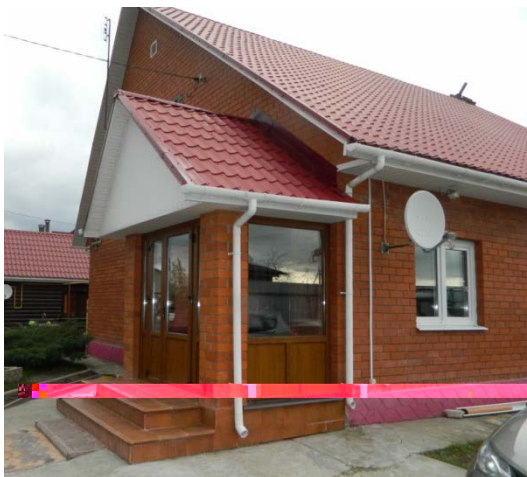
Рис. 160. Закрытая конструкция крыльца
