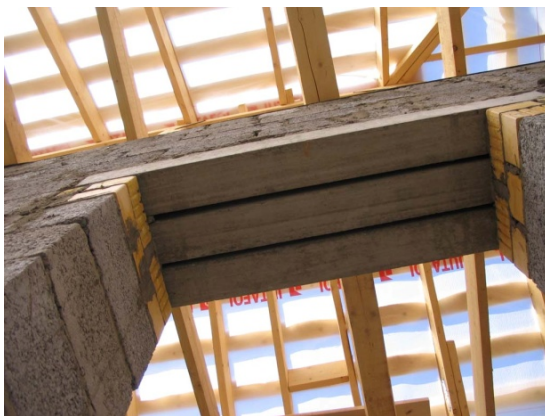
Рис. 79. Брусковые перемычки над дверным проемом
