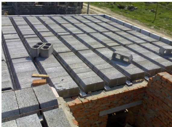
Рис. 56. Сборно-монолитное перекрытие
