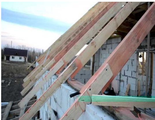
Рис. 104. Устройство кобылок
