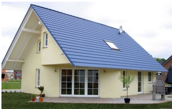
Рис. 115. Кровля из цементно-песчаной черепицы
