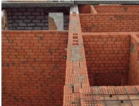
Рис. 17. Внутренняя стена жилого дома с вентиляционными каналами
