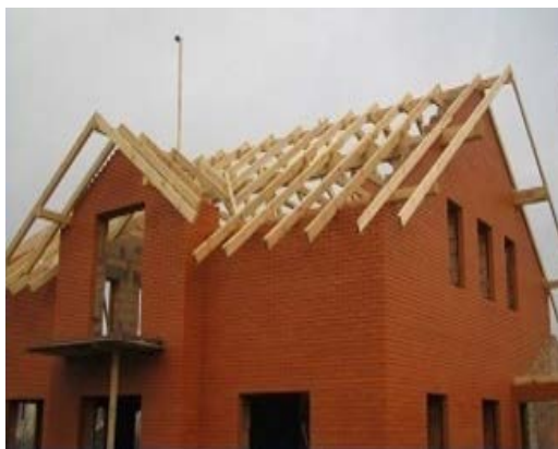
Рис. 96. Установка консольного прогона
