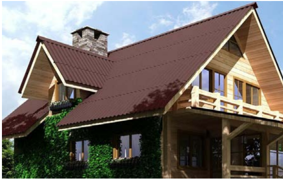
Рис. 125. Кровля из еврошифера
