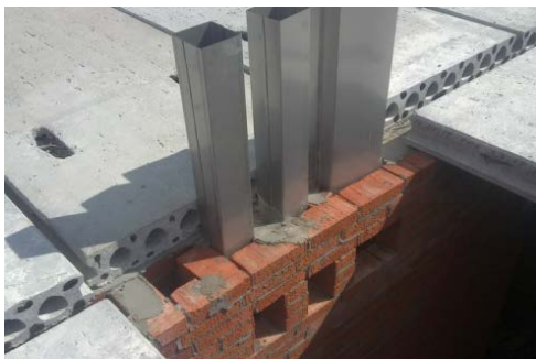
Рис. 60. Пропуск вентиляционных каналов через сборное железобетонное перекрытие
