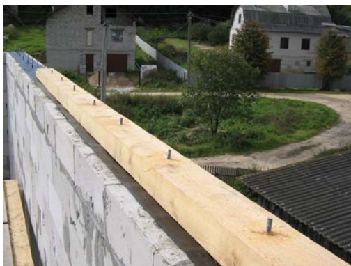
Рис. 94. Установка мауэрлата на наружную стену
