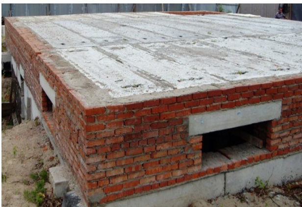
Рис. 51. Пример перекрытия над подвалом
