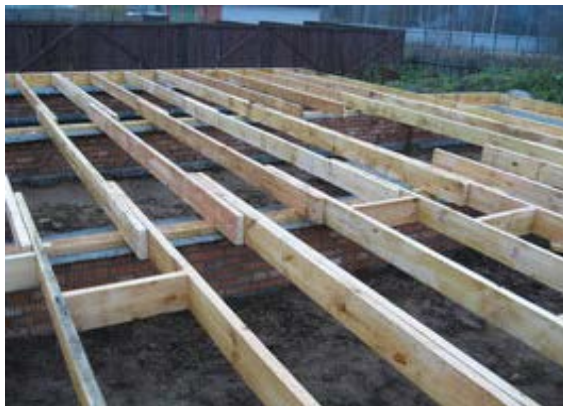
Рис. 52. Пример цокольного перекрытия
