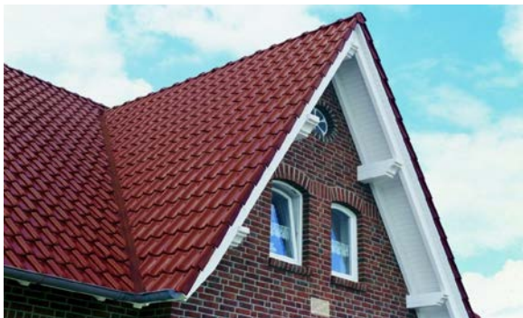
Рис. 110. Кровля из керамической черепицы
