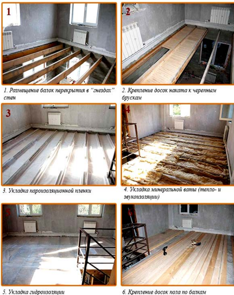
Рис. 67. Устройство перекрытия по деревянным балкам
