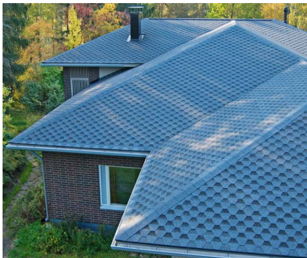
Рис. 119. Кровля из битумной черепицы
