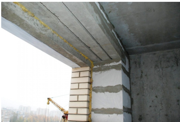
Рис. 74. Верхний простенок над оконным проемом
