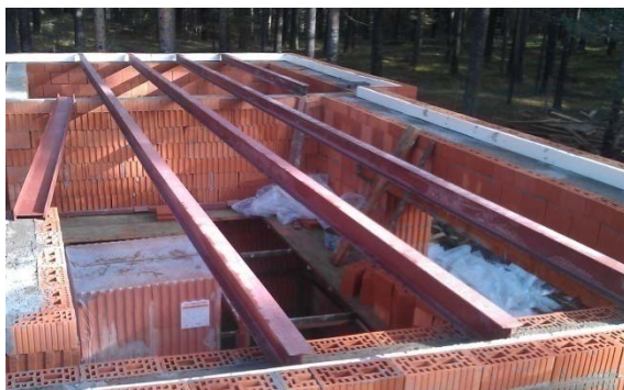
Рис. 58. Устройство перекрытия по металлическим балкам
