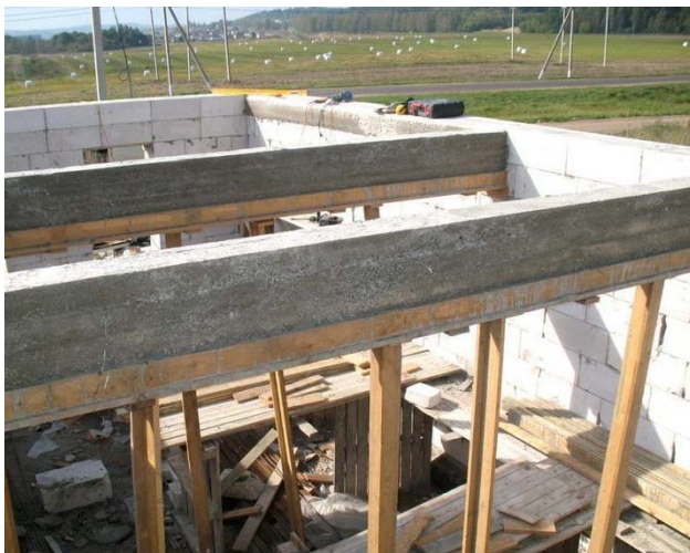
Рис. 59. Устройство железобетонных балок перекрытия на месте строительства
