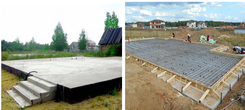
Рис. 38. Плитный фундамент
