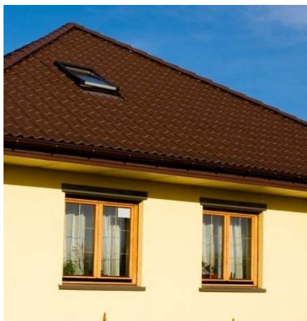
Рис. 70. Окна в стене и крыше дома
