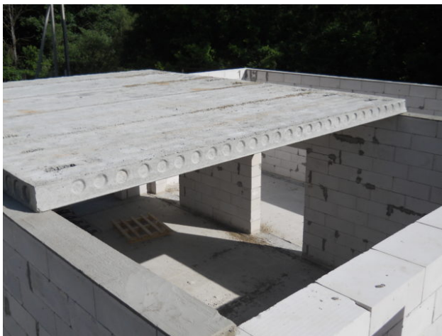
Рис. 53. Сборное железобетонное перекрытие из плит железобетонных круглопустотных
