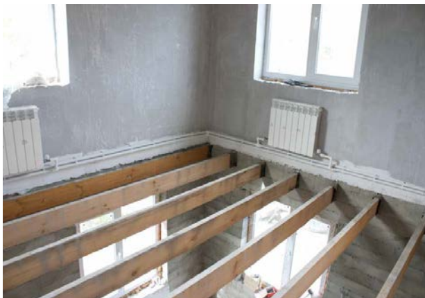
Рис. 50. Пример межэтажного перекрытия
