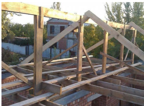
Рис. 95. Установка прогона
