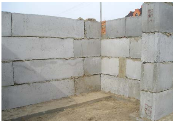
Рис. 48. Сборный ленточный фундамент
