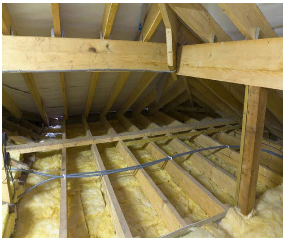
Рис. 49. Пример чердачного перекрытия
