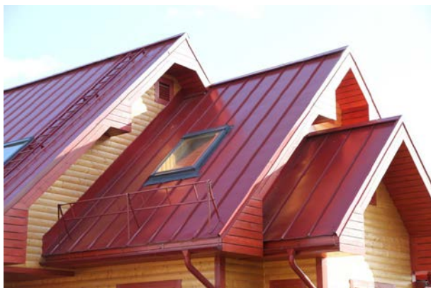
Рис. 109. Фальцевая кровля
