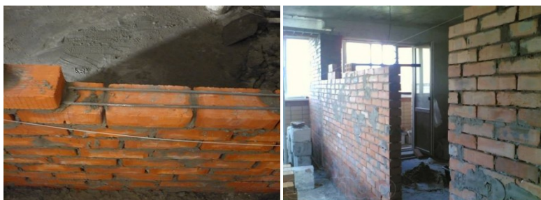
Рис. 26. Межкомнатные перегородки из кирпича
