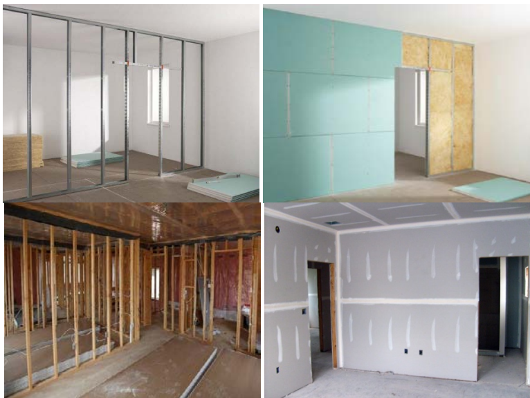
Рис. 28. Перегородки из гипсокартонных листов
