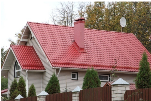
Рис. 107. Кровля из металлочерепицы
