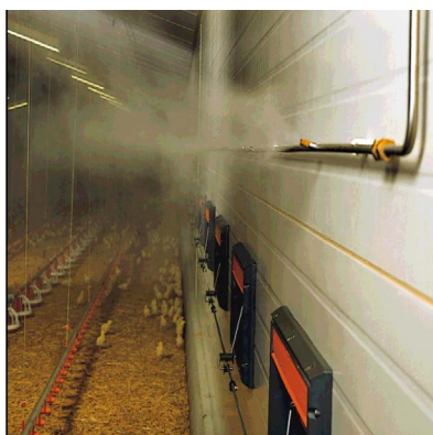
Рис. 1.4. Система увлажнения с форсунками высокого давления
