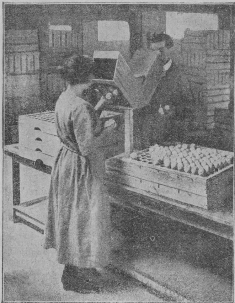
Рис. 192. Аппарат „Daylight Tester“ с электрическим светом для просмотра яиц, применяемый в Англии.
