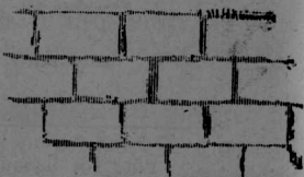
Рис. 17. Кирпичная кладка подъ столбами этажерокъ въ Саксенгаузенскомъ плодохранилищѣ.
