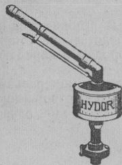
Рис. 169. Дождевальный аппарат-брандспойт
