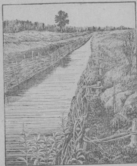
Рис. 66. Разрушение плетневого крепления откоса
