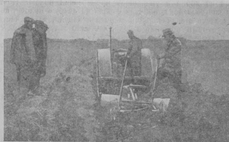
Рис. 185. Треугольный канавокопатель
