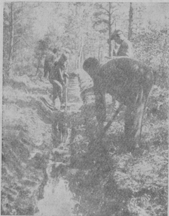
Рис. 84. Копка канав вручную
