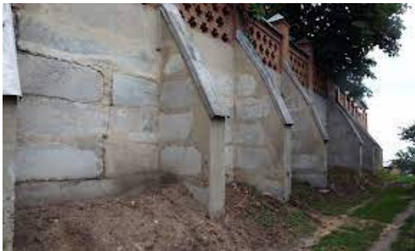
Рис. 1.52. Сборная бетонная конструкция подпорной стены с контрфорсами
