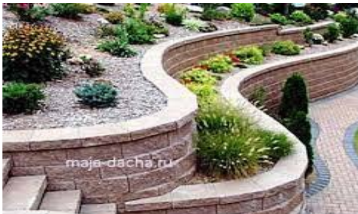
Рис. 1.13. Подпорные стенки на грунтовых террасах
