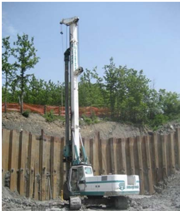
Рис. 1.73. Шпунтовое ограждение котлованов
