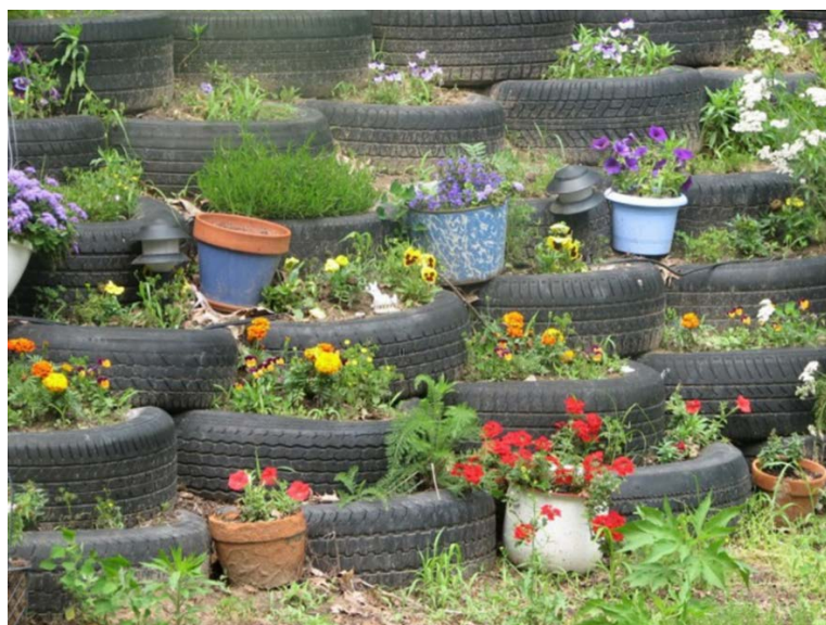
Рис. 1.65. Подпорная стенка из автопокрышек
