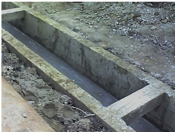
Рис. 1.72. Стенки канавы из бетона
