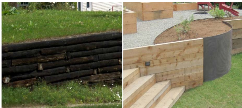
Рис. 1.64. Деревянная подпорная стенка – горизонтальная
