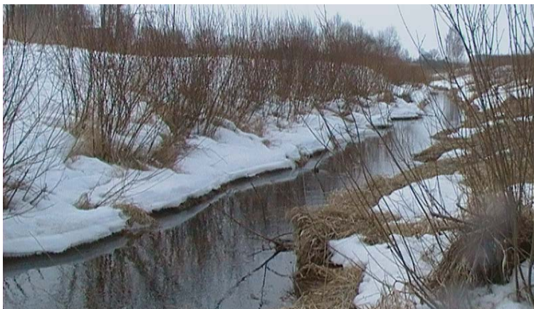
Рис. 1.3. Вид канала с нескошенной древесно-кустарниковой растительностью
