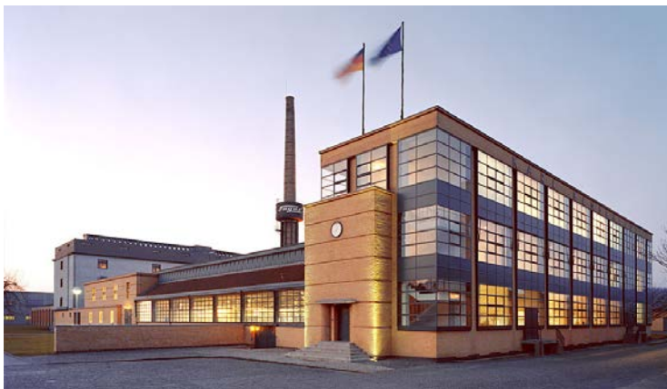
Рис. 51. Здание фабрики «Фагус» в г. Альфельд, Германия (В. Гропиус, А. Майер, 1911–1912 гг.)
