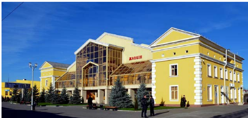
Рис. 165. Железнодорожный вокзал в Жлобине (О. Тихова, реконструкция 2000-х гг.)
