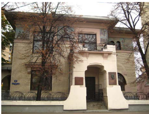
Рис. 98. Особняк Рябушинского в Москве (Ф. Шехтель, 1900–1902 гг.)
