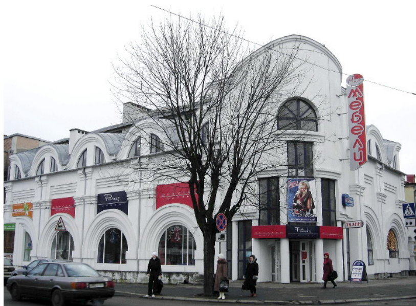
Рис. 171. Торговый дом по ул. Комсомольской, д. 2 в Бресте (В. Кескевич, Ю. Пруделюк, 1995–1997 гг.)
