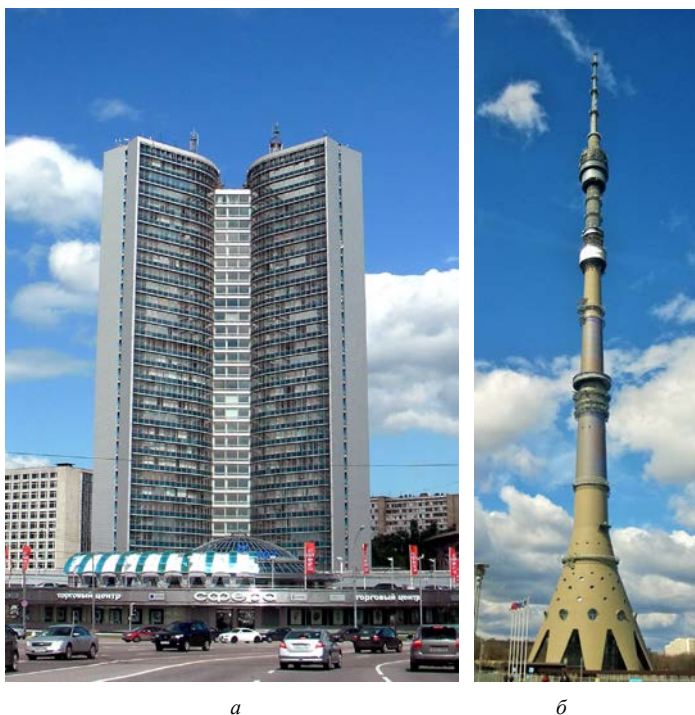
Рис. 107. Здание СЭВ (1963–1970 гг.) (а) и Останкинская телебашня в Москве (1967 г.) (б)
