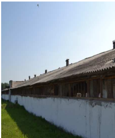
Рис. 2. Свиноарник до реконструкции
