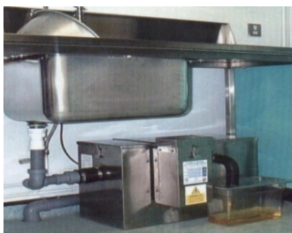
Рис. 1. Механический жироуловитель
