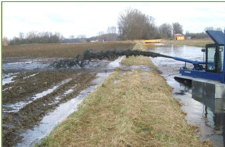
Рис. 6.6. Вид работы земснаряда-амфибии с выбросной трубой.
