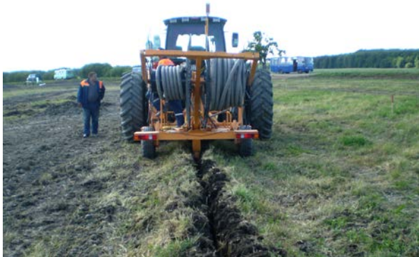
Рис. 2.27. Оборудование МДИ в работе
