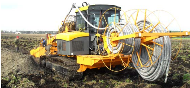
Рис. 2.35. Экскаватор-дреноукладчик ЭТЦ-203 в работе
