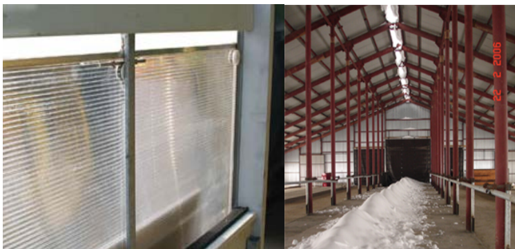
Рис. 53. Подвижные панели из поликарбоната для вентиляции коровника
