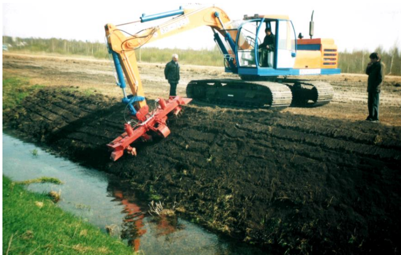
Уходные работы на канале
