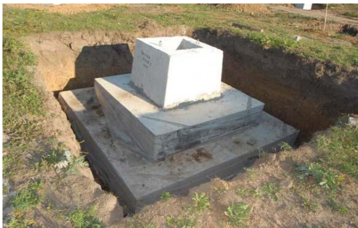
Рис. 11.1. Столбчатый фундамент стаканного типа
