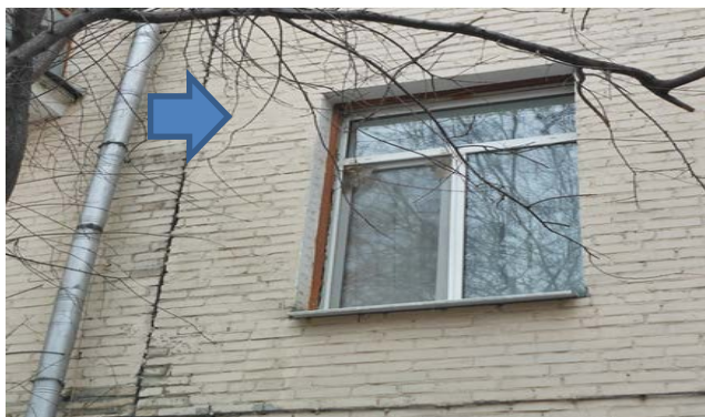
Рис. 2.2. Температурный шов здания
