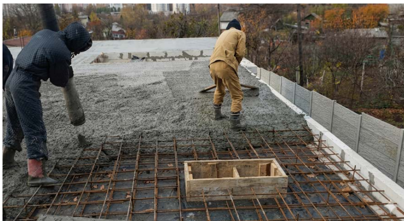
Рис. 5.3. Устройство монолитного перекрытия
