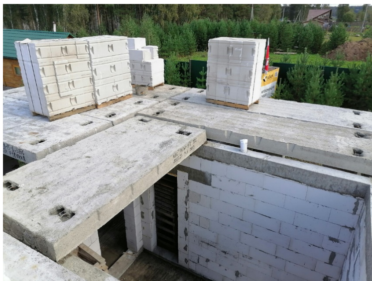
Рис. 5.2. Плита перекрытия
