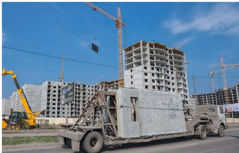
Рис. 8.1. Железобетонные панели используют для возведения стен зданий
