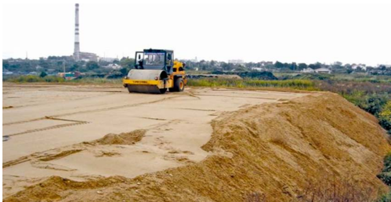
Рис. 3.1. Уплотнение грунта катком
