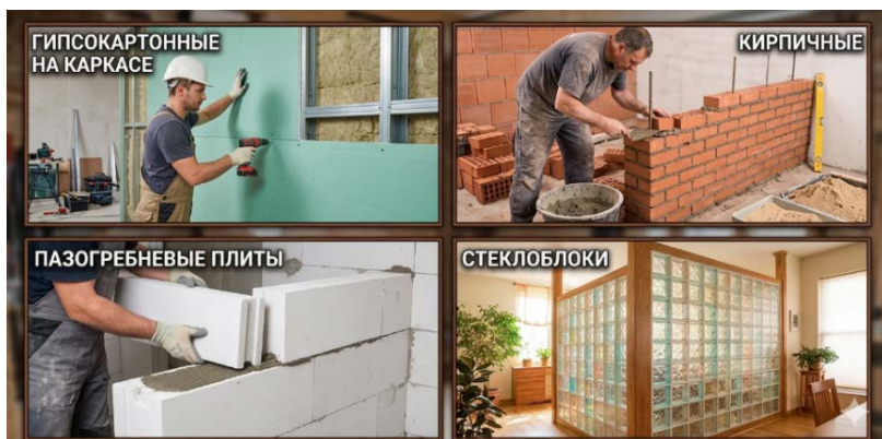
Рис. 4.5. Виды перегородок по материалу
