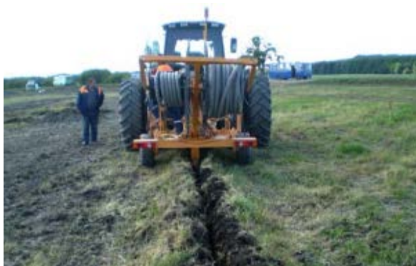
Рис. 11.7. Оборудование МДИ в работе
