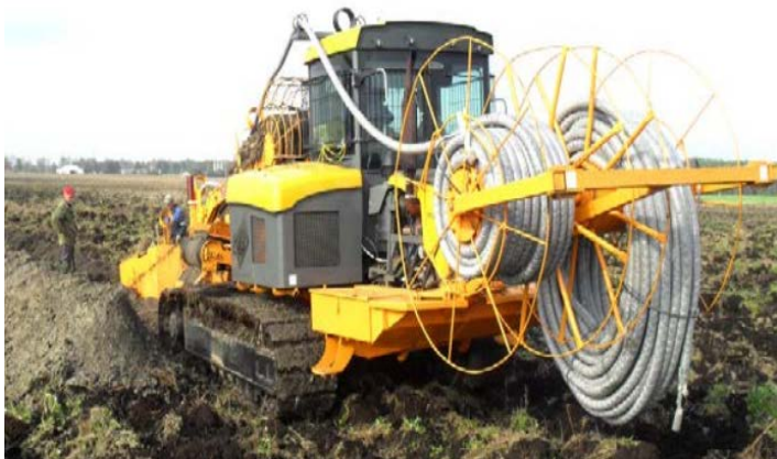
Рис. 11.2. Экскаватор-дреноукладчик с лазерным уклономером ЭТЦ-203
