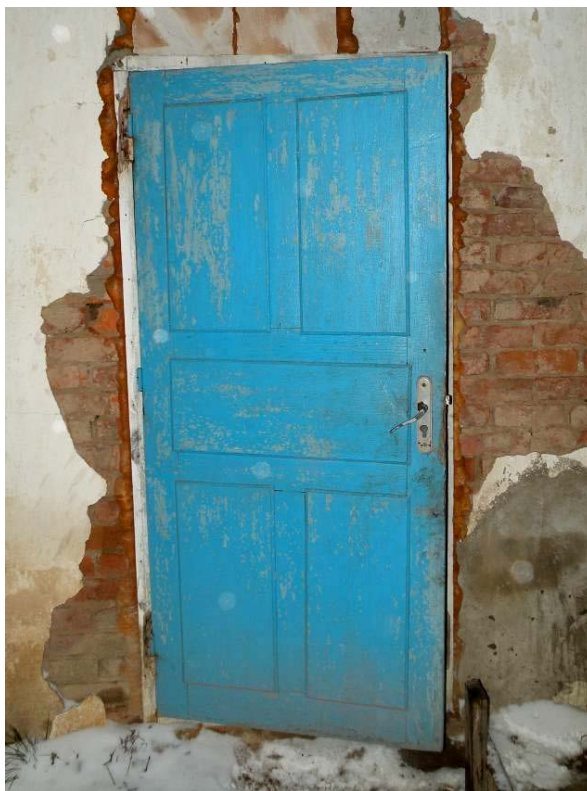
Фото № 3. Общий вид входной двери в дом
