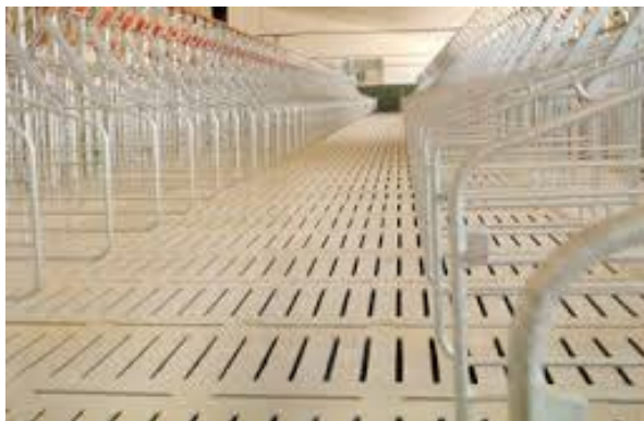
Рис. 3.2. Устройство полов в свинарниках
