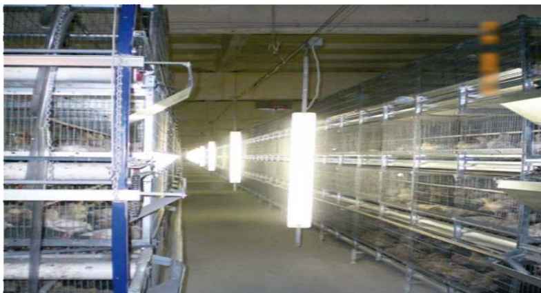
Рис. 4.12. Освещение птичников для выращивания бройлеров
