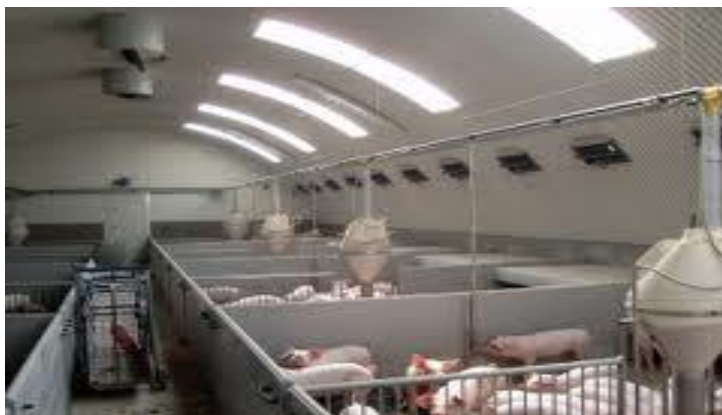
Рис. 3.17. Верхние окна для освещения в помещениях для свиней
