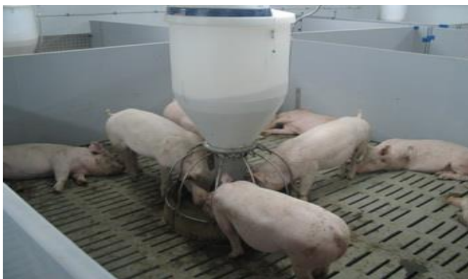
Рис. 3.5. Бетонные щелевые полы
