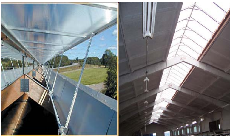
Рис. 46. Вентиляционный и светоаэрационный конек
