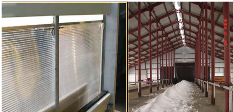
Рис. 48. Подвижные панели из поликарбоната для вентиляции коровника
