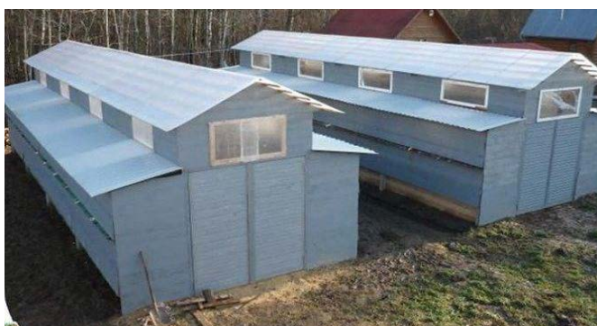
Рис. 11.5. Наружный вид шеда с двухъярусным расположением клеток
