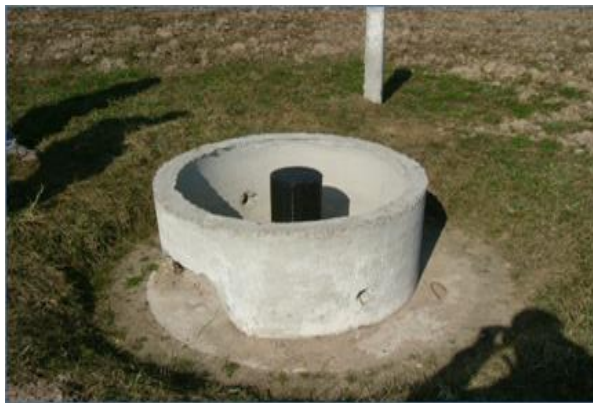
Рис. 4.16. Колодец-поглотитель (крышка снята)
