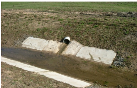
Рис. 4.10. Асбестоцементное дренажное устье
