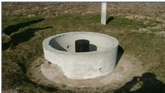
Рис. 4.11. Колодец-поглотитель (крышка снята)
