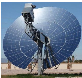
Рис. 2. Солнечная тарелка Suncatcher
