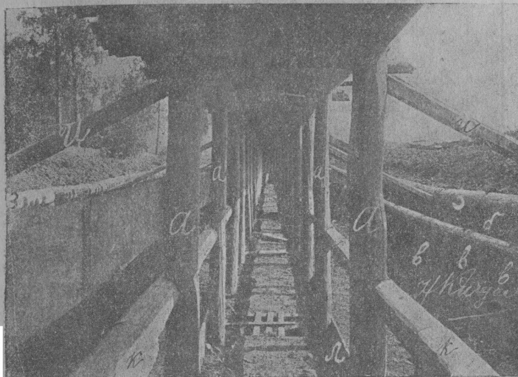
Рис. 6. Внутренний вид по середине остова шампильонницы в конце шампильонной кампании.
