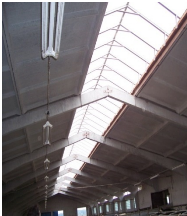
Рис. 28. Вентиляционный и светоаэрационный конек
