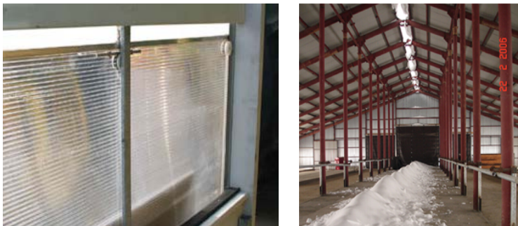
Рис. 30. Подвижные панели из поликарбоната для вентиляции коровника
