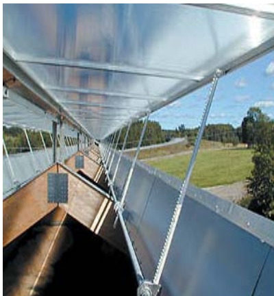
Рис. 28. Вентиляционный и светоаэрационный конек
