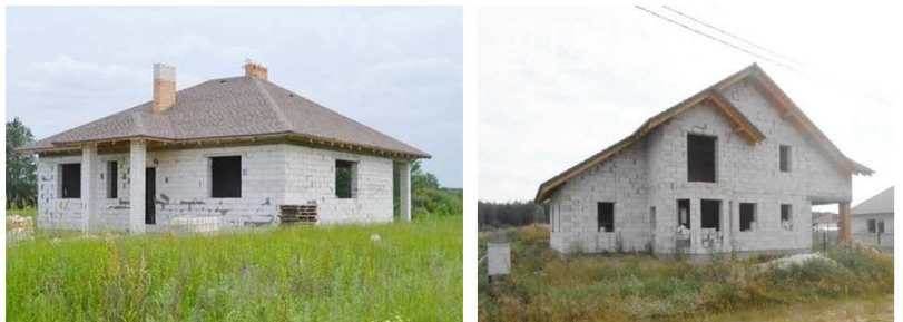
Рис. 9.3. Незавершенное законсервированное капитальное строение
