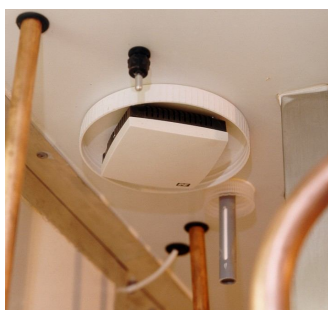
Рис. 63. Регулятор \text{CO}_2 и другие датчики контроля в предварительном инкубаторе
