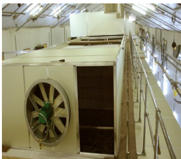
Рис. 95. Теплообменник
