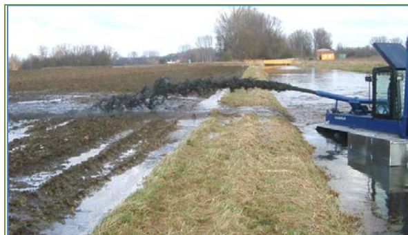
Рис. 8.6. Вид работы земснаряда-амфибии с выбросной трубой
