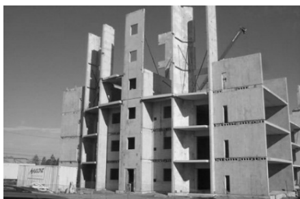
Рис. 2. Здание, построенное с помощью железобетонных плит
