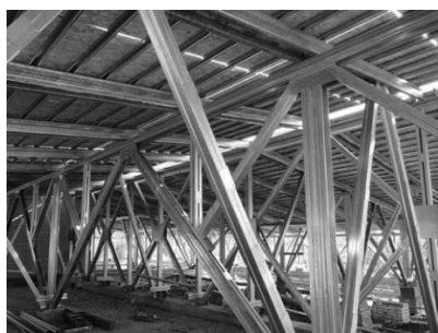
Рис. 3. Здание, построенное на основе металлоконструкций
