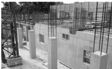
Рис. 1. Здание, построенное методом монолитной заливки
