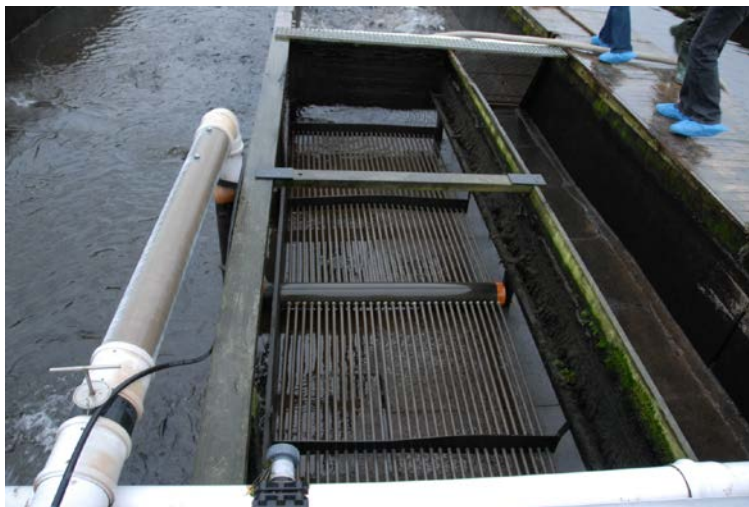
Рис. 5.39. Низконапорный диффузор (в выключенном режиме)
