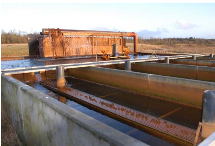
Рис. 5.47. Колонна удаления железа
