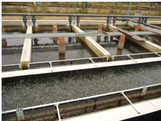
Рис. 5.17. На переднем плане изображен биофильтр с плавающей загрузкой
