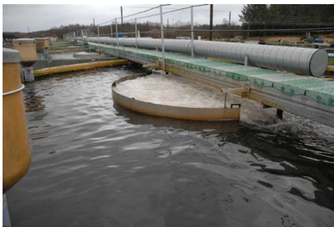
Рис. 5.36. Диффузор низкого давления в центре круглого бассейна
