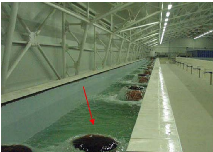
Рис. 21. Лоток сбора воды открытого типа (бетон). Стрелкой указан телескопический слив совместно и контроль уровня воды в бассейне
