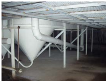
Рис. 2. Фермерское хозяйство «Василек» Дзержинского р-на. Отличительной особенностью данной УЗВ являются стальные бассейны с наклонным дном и конусом для сбора шлама, а также эрлифты
