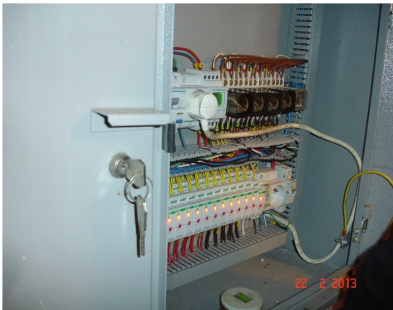
Рис. 5.57. Система контроля за продолжительностью светового дня
