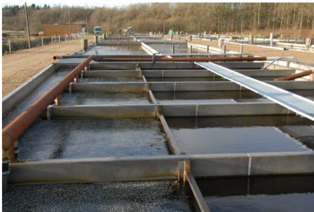
Рис. 5.30. Биофильтр с псевдооживленным слоем
