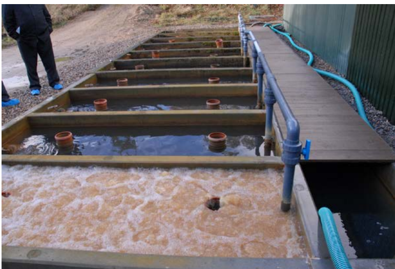
Рис. 5.45. Промыка фильтра сжатым воздухом
