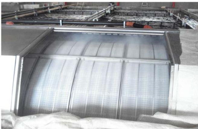
Рис. 11. Барабанный механический микрофильтр Нудротех с ячейей сетки 40 мкм
