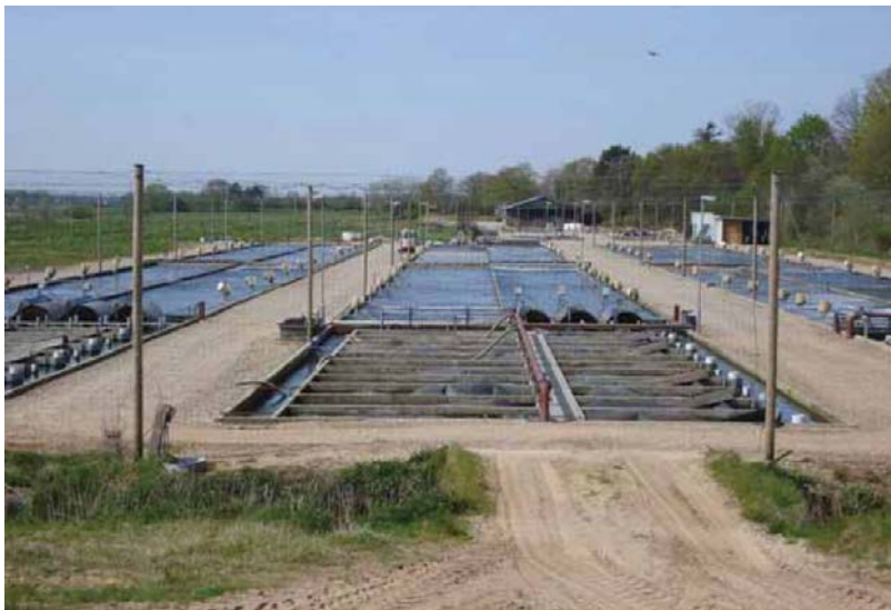
Рис. 3.7. Образцовое форелевое хозяйство Kongeåens (тип 3). Производственные подразделения включают в себя три секции, каждая из которых состоит из двух бетонных дорожек с микроситами (размер ячейки – 74 мкм) перед секцией биофильтра (на переднем плане). Слева расположены биологические пруды, состоящие из бывших земляных прудов и впускных и выпускных каналов (Svendsen et al., 2008)
