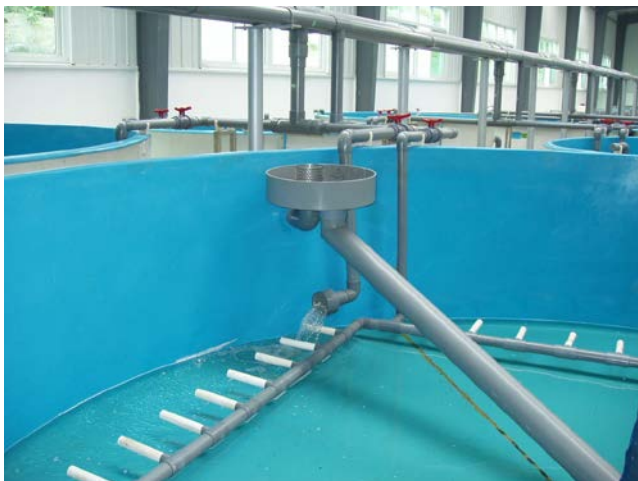
Рис. 5.10. Максимальная аэрация воды в некоторых УЗВ Китая (пример 2)
