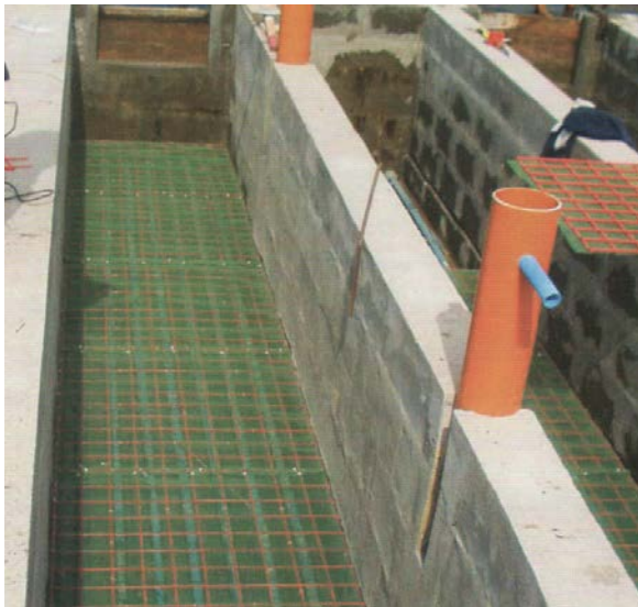
Рис. 5.23. Распылители для промывки биофильтра с погружной загрузкой с монтированной поверх них сеткой для удержания биоагрузки
