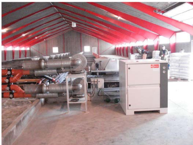
Рис. 8. Воздуховки CAPSEL и VENTURI для аэрации и дегазации с производительностью 1500 м 3 /ч
