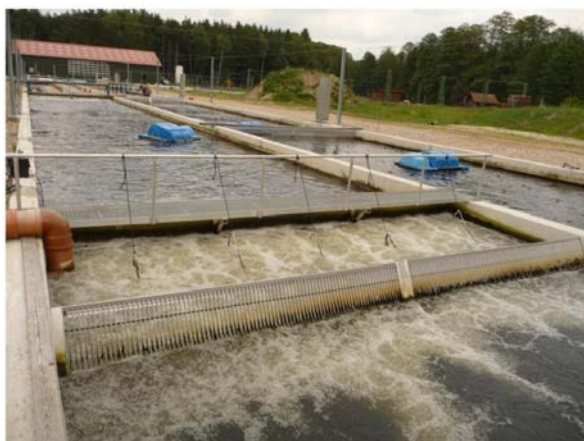
Рис. 5.6. Работа эрлифта в действующих рыбоводных хозяйствах (пример 2)
