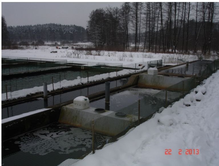
Рис. 5.52. Отстойники для родниковой воды
