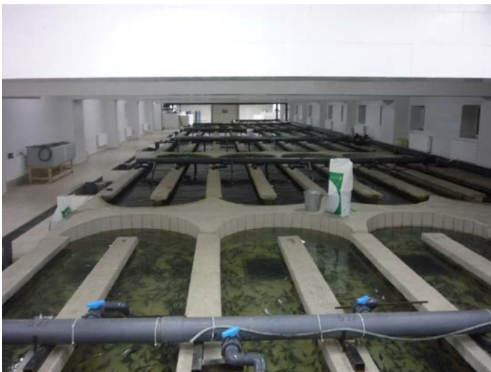
Рис. 27. УЗВ с бетонными бассейнами овальной формы
