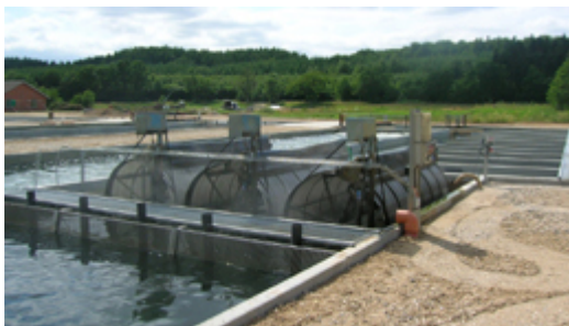
Рис. 5.15. Механический барабанный фильтр (микрофильтр)
