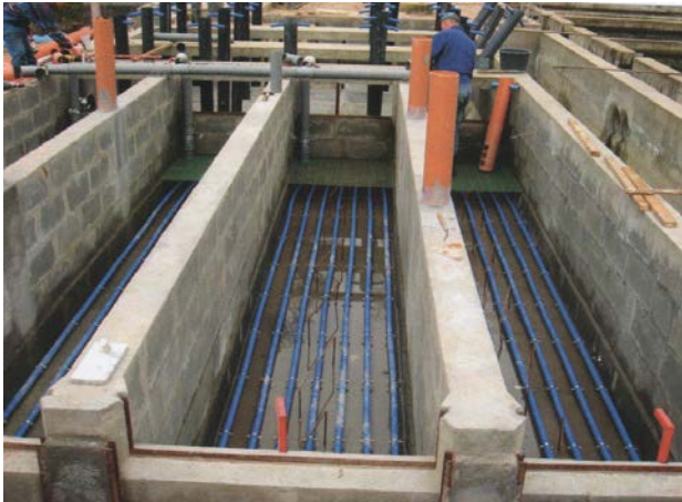
Рис. 5.22. Распылители для промывки биофильтра с погружной загрузкой
