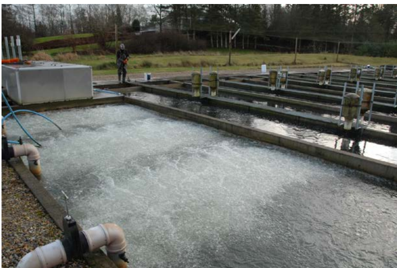
Рис. 5.43. Отдувка воды
