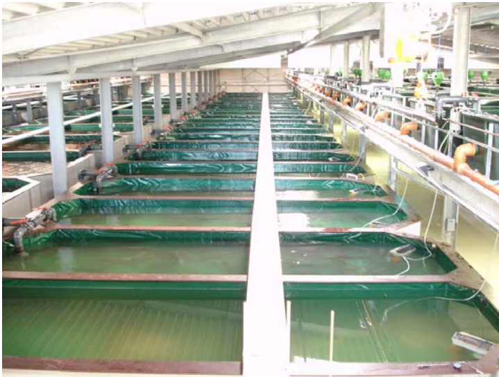
Рис. 16. Схема УЗВ с бетонными прямоугольными бассейнами (вариант 3)
