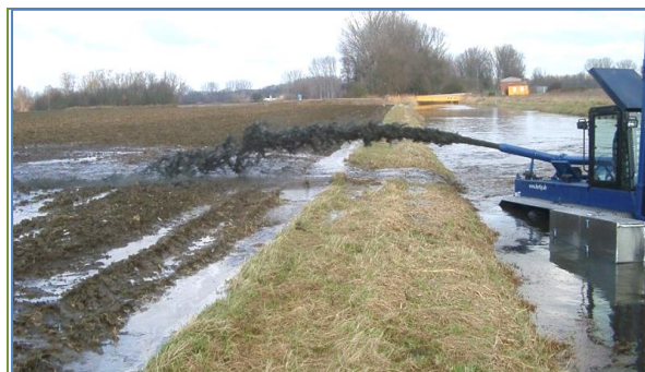
Рис. 8.6. Вид работы земснаряда-амфибии с выбросной трубой
