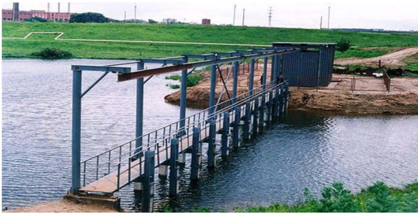
Рис. 7.25. Рыбозащитные сооружения насосной станции Костромской низины
