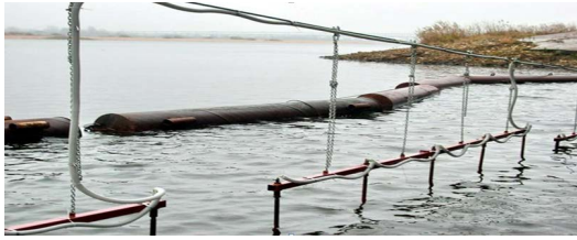
Рис. 7.24. Рыбозащитное устройство типа «униполярный электрорыбозаградитель» для береговой насосной станции Сормовской ТЭЦ
