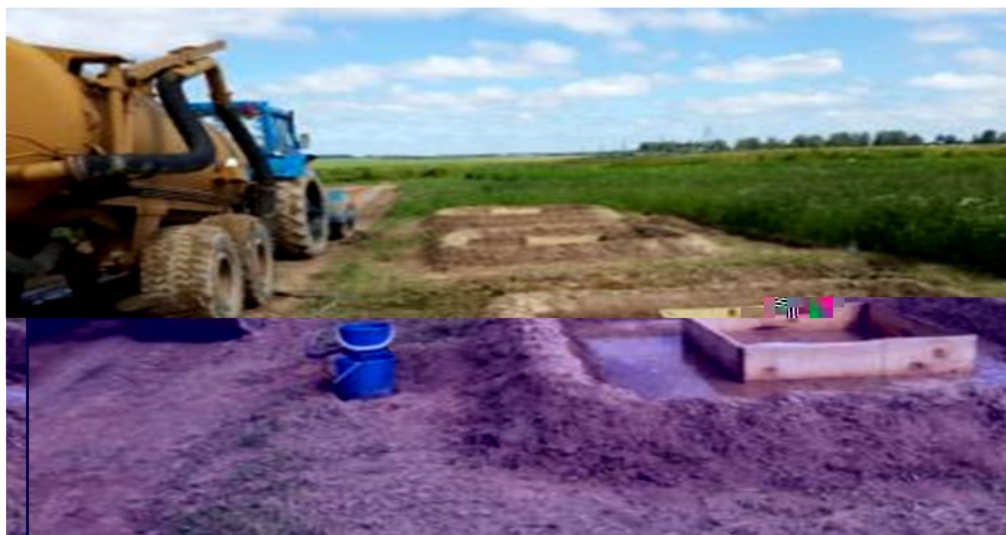
Рисунок 3. – Заливка площадок водой
