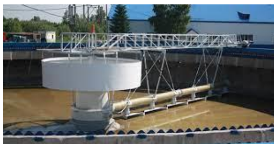
Рис. 3. Радиальный отстойник
