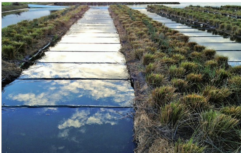
Рис. 47. Доочистка воды на очистных станциях
