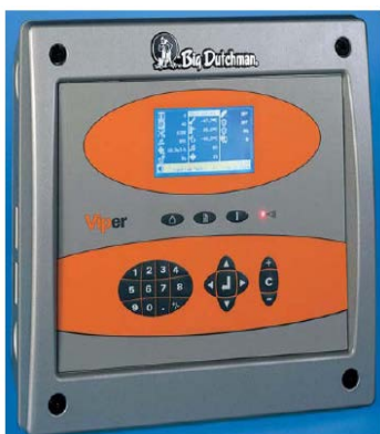
Рис. 1.7. Блок управления микроклиматом
