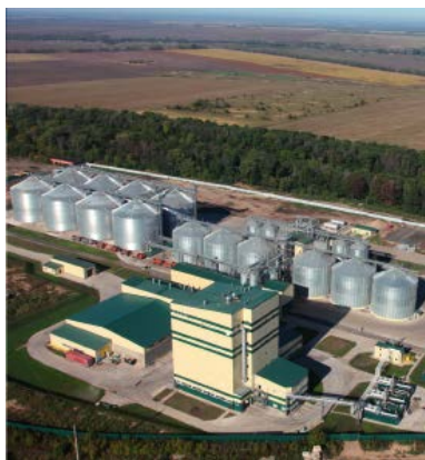
Рис. 1.16. Комбикормовый завод производительностью 30 т в час с зернохранилищем на 78 тыс. т
